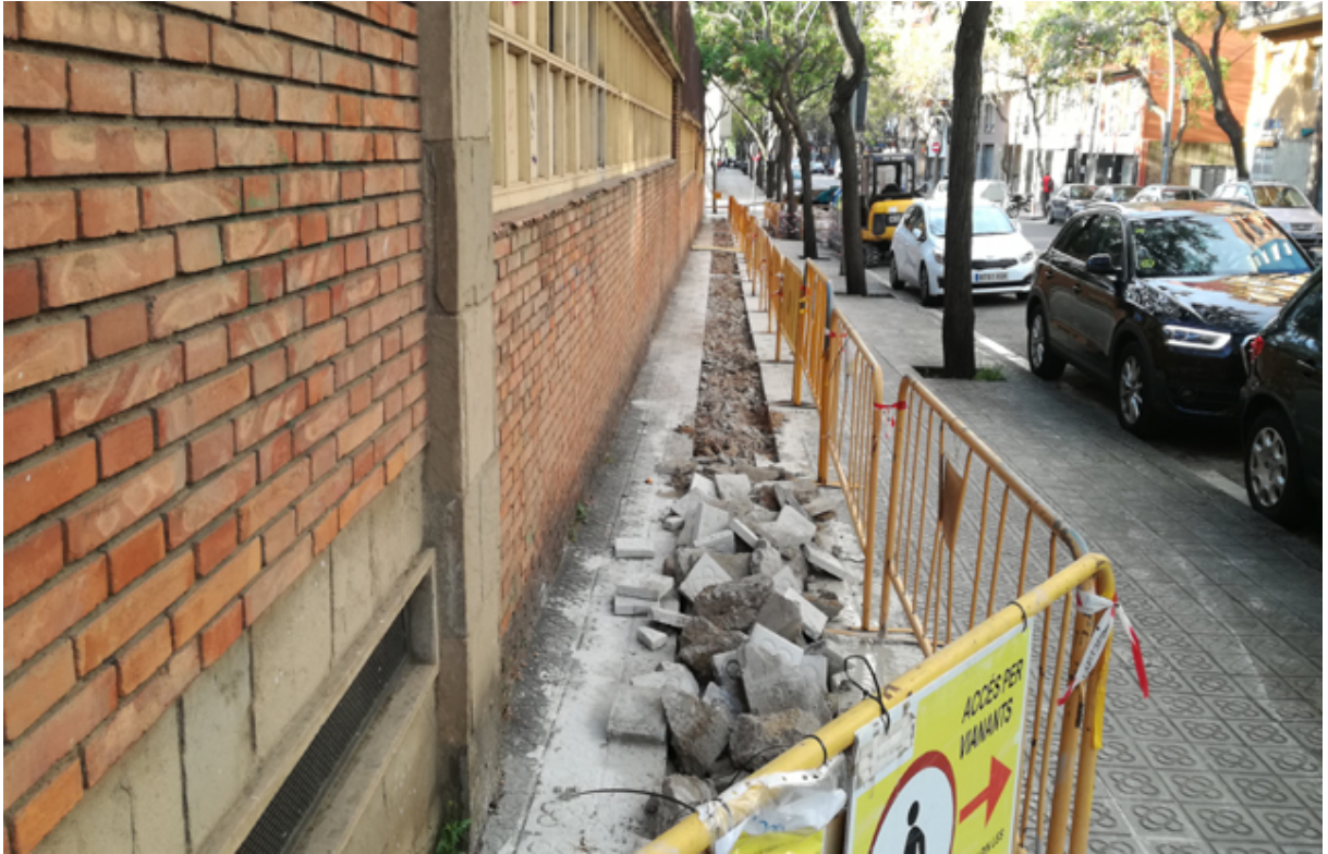
FOTOGRAFIA 5 → Fotografia durant les tasques d'obertura de la rasa, un cop extretes les rajoles de la vorera, des del nord.
