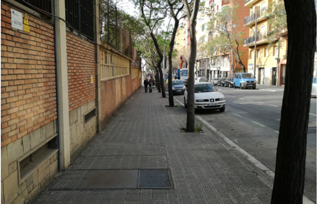
FOTOGRAFIA 2 → Imatge de la situació de la intervenció, justament a on havia d'arribar la rasa, on trobem l'estació transformadora (ET), des del nord.
